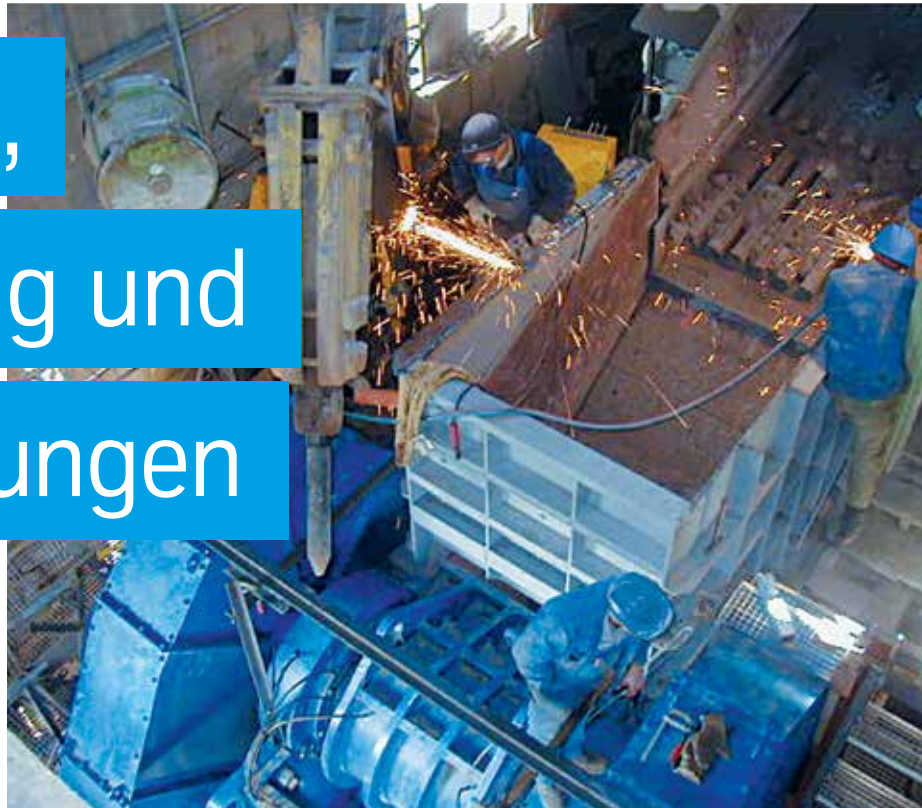
Modernisierung des Steinbruchs durch Einbau des leistungsstarken Kurbelschwingerbrechers
